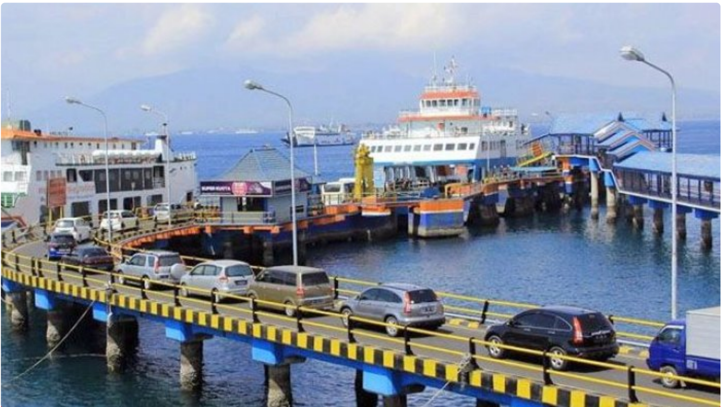
Pelabuhan penyeberangan Ketapang Banyuwangi
